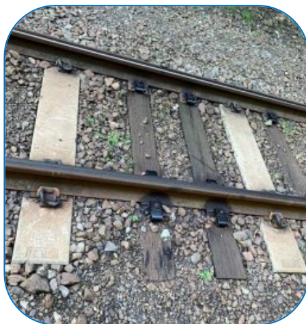
【トンネルマクラギ 1/3 コンクリート化】
