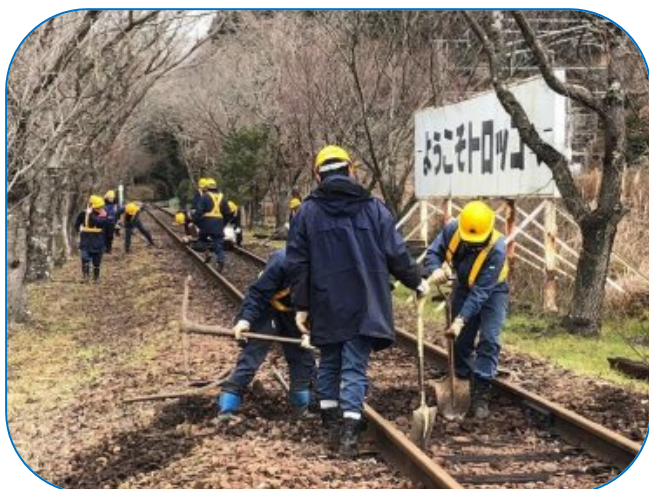
【トロッコ亀岡駅構内マクラギ交換】
